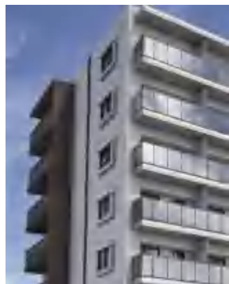
東京押上/東京住宅
